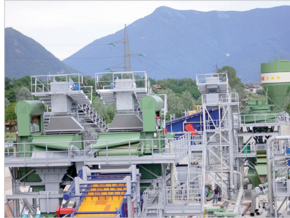
Sand- und Kieswerk in Norditalien. Komplettes Werk mit Schaltanlage, Elektroinstallation und Visualisierung
